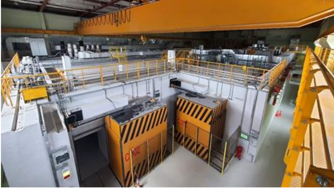
C blok: İç Bina: Güvenlik kapıları
