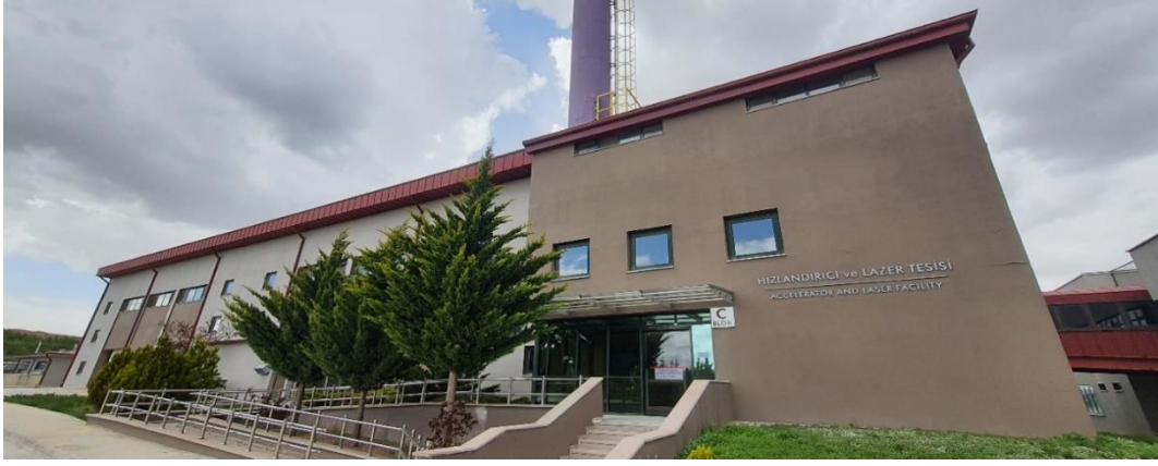
C blok: Dış Bina: Elektron hızlandırıcı ve araştırma laboratuvarları
