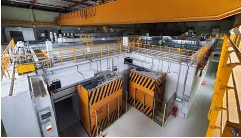
C blok: İç Bina: Güvenlik kapıları
